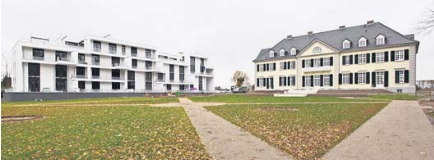
Starke Gegensätze: Der kubistische Neubau und das neoklassizistische Schloss stehen für unterschiedliche Architektur-Epochen.
