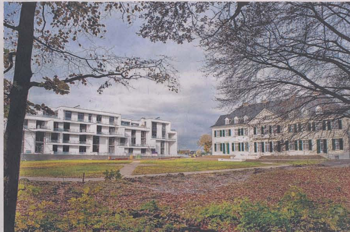
Links der Neubau nach einem Entwurf von Thomas Pink , rechts das sanierte neoklassizistische Schloss von 1910. Dieser Kontrast von Alt und Neu hat es Rainer Kohl angetan. Deshalb wollte er eine stilistische Zäsur . RP-FOTOS: MATZERATH
